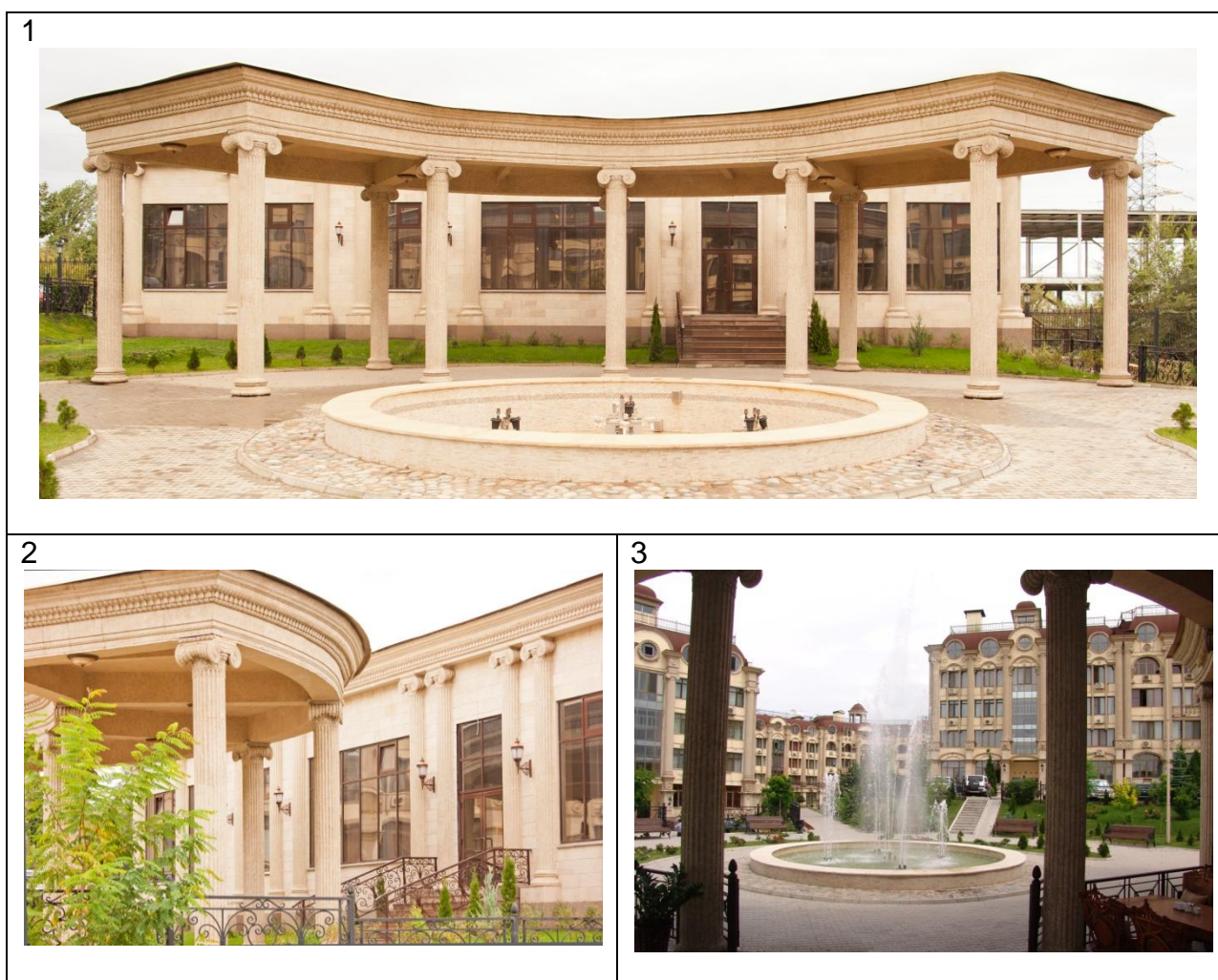
Рисунок 55. Комплекс «Европолис», г.Алматы, ресторан, «Европолис», 2010: 1 – Общий вид [181]; 2 – Фрагмент [181]; 3 – Вид из под колоннады [181].
