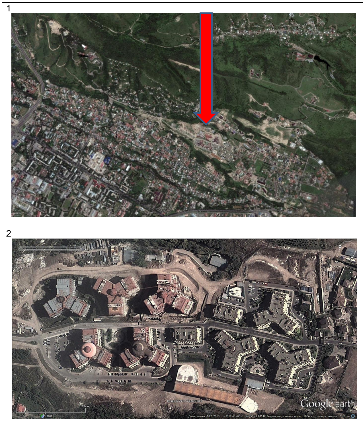
Рисунок 43. Комплекс «Европолис» в г.Алматы: 1 – Местоположение комплекса в Медеуском районе (аэрофотосъемка «Google-Earth») [181]; 2 – Основная часть комплекса (аэрофотосъемка «Google-Earth») [181].
