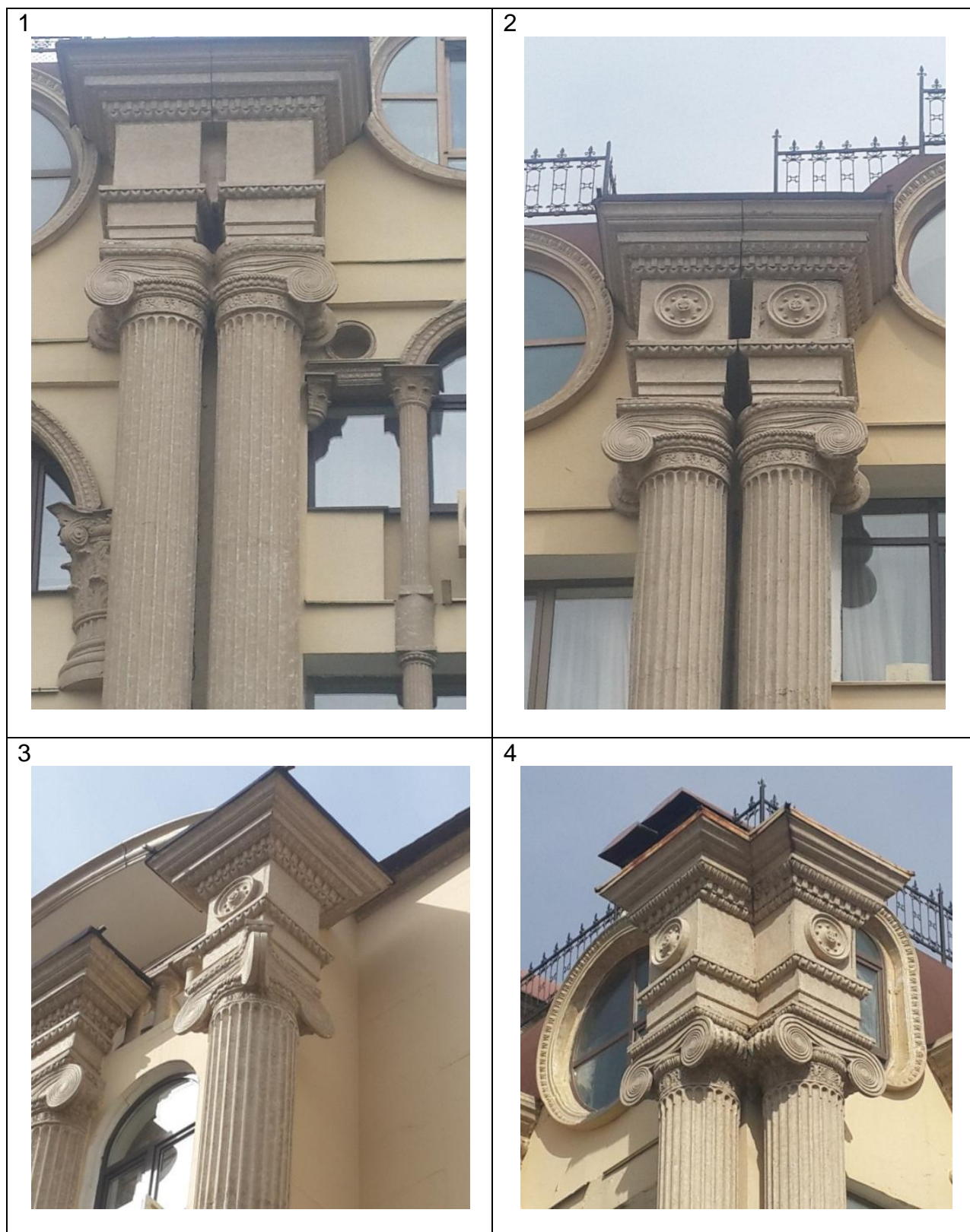
Рисунок 62. Комплекс «Европолис», г.Алматы, «Европолис», жилые дома типа «Трилистник» и «Элеганс»: 1 – Парные одноволютные ионические колонны в пятнах 1 и 2; 2 – Парные одноволютные ионические колонны в пятнах 3, 4 и 5; 3 – Угловая однорогая ионическая колонна в пятнах 1, 2, 3, 4 и 5; 4 – Парные угловые ионические колонны в пятнах 1, 2, 3, 4 и 5[материалы компании «Европолис»].
