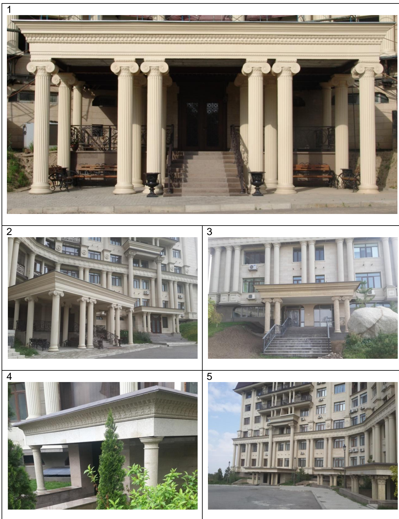
Рисунок 66. Комплекс «Европолис», г.Алматы, «Европолис», портики входов в коммерческие помещения цокольного этажа: 1, 2, 3, 4 – жилой дом типа «Империмум» (пятно 7); 5 – жилой дом типа «Империмум» (пятно 9) [материалы компании «Европолис»].
