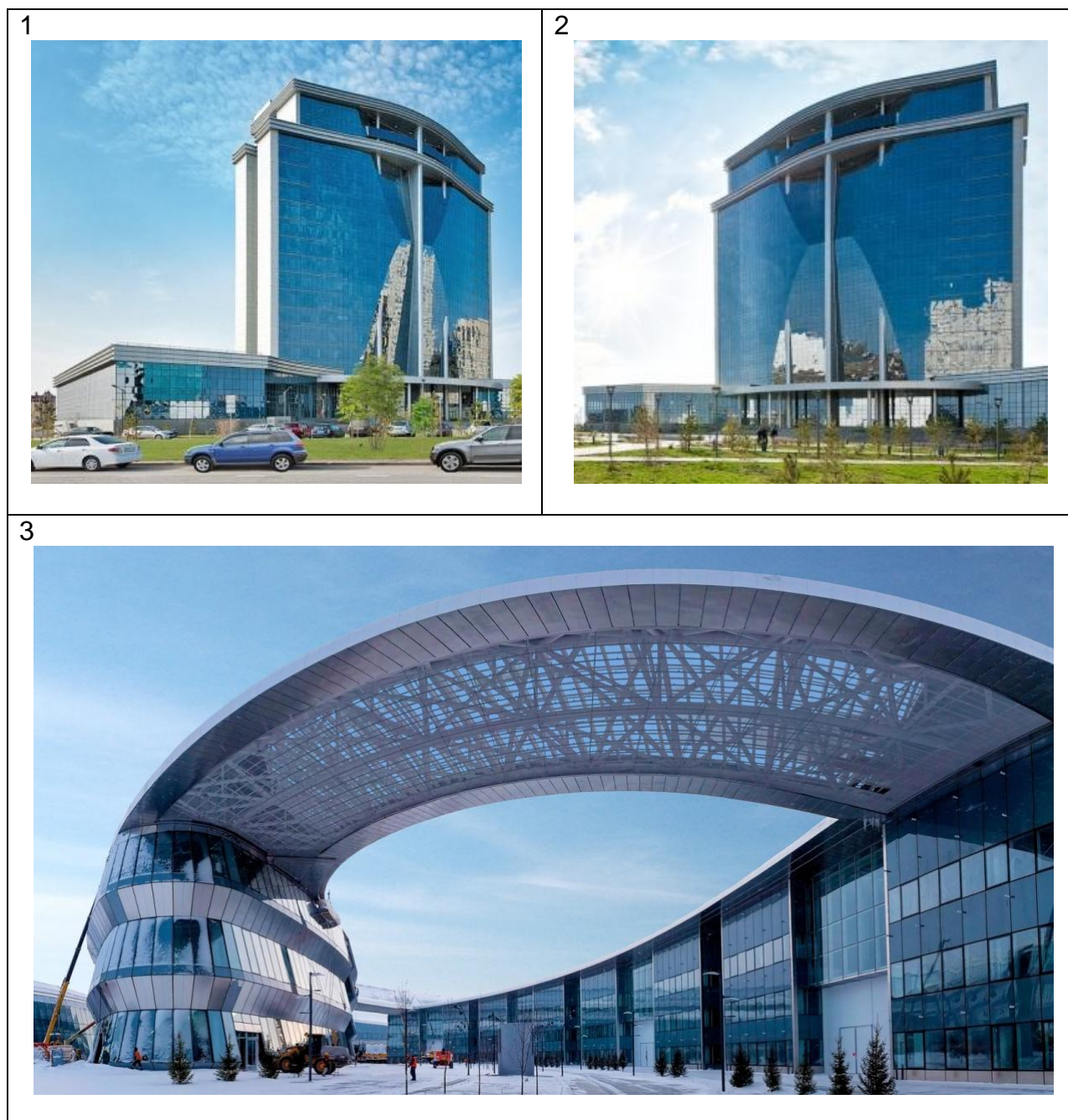
Рисунок 25. 1, 2 – Офис компании «Казахстанская компания по управлению электрическими сетями», г.Нур-Султан, «Базис-А», 2013 [230]; 3 – Выставочный комплекс EXPO-2017, г.Нур-Султан, «Базис-А», 2016 [231].
