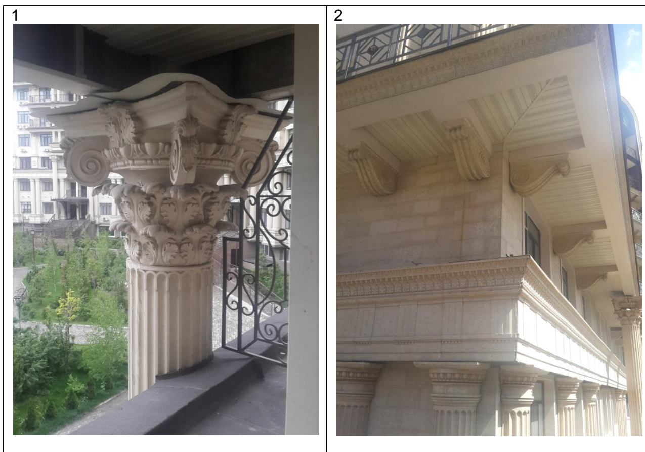
Рисунок 65. Комплекс «Европолис», г.Алматы, «Европолис», жилой дом типа «Империмум»: 1 – Композитная капитель (пятно 9); 2 – Подбалконные кронштейны (пятно 6) [материалы компании «Европолис»].
